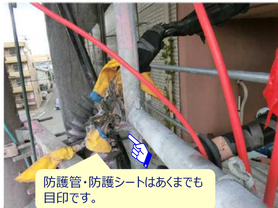
<防護シートを取り付けていたものの、火災が発生した箇所>
